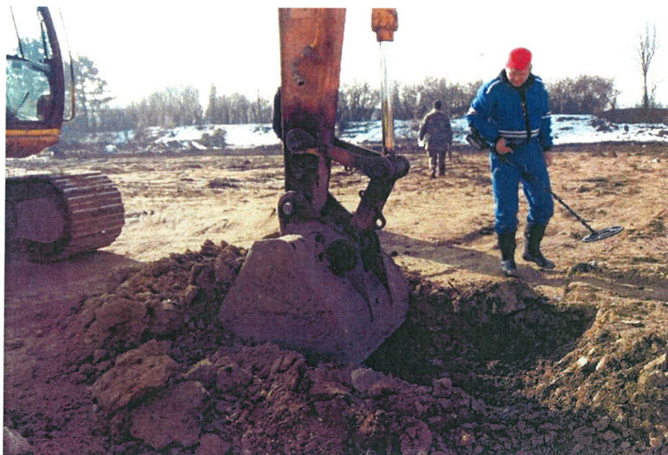
Obr.4 Pozice všech naměřených bodů byly přeneseny do terénu a následně byly ověřeny kopanou sondou (bagrem) pod trvalým dozorem pyrotechnika. Pyrotechnik s detektorem při prověře signálu.
