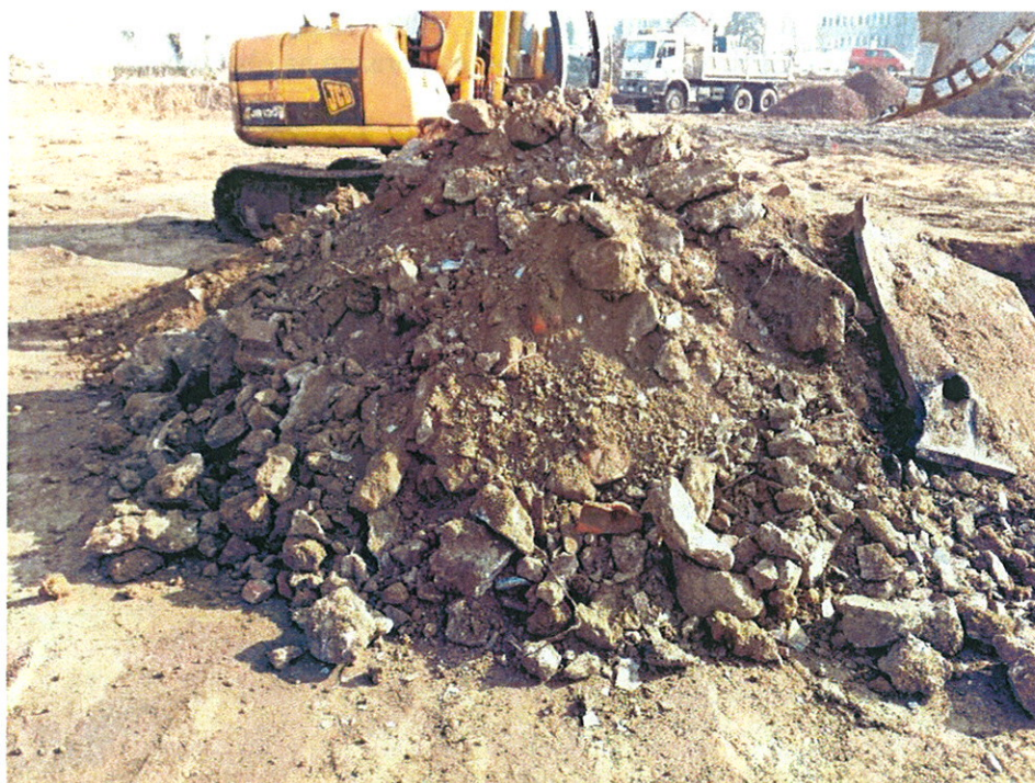
Obr.7 Při prověrcce signálu č.1 bylo zjištěno, že se jedná o prohlubeň (pravděpodobně kráter po bombě) zaplněný stavební sutí, rozměrnými železobetonovými bloky, plechy a podobným stavebním odpadem.
