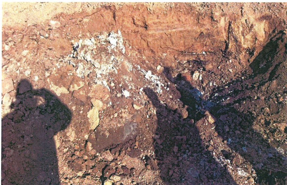
Obr.6 Tepelná izolace (skelná vata) nalezená ve výkopu. Vzhledem k tomu, že se nejedná o pyrotechnický materiál, ale o odpadní jámu mimo obvod budovy, byly výkopové práce zastaveny
