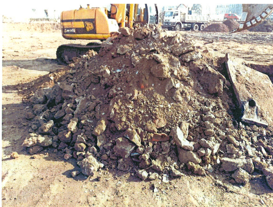
Obr.7 Při prověrkce signálu č.1 bylo zjištěno, že se jedná o prohlubeň (pravděpodobně kráter po bombě) zaplněný stavební sutí, rozměrnými železobetonovými bloky, plechy a podobným stavebním odpadem.
