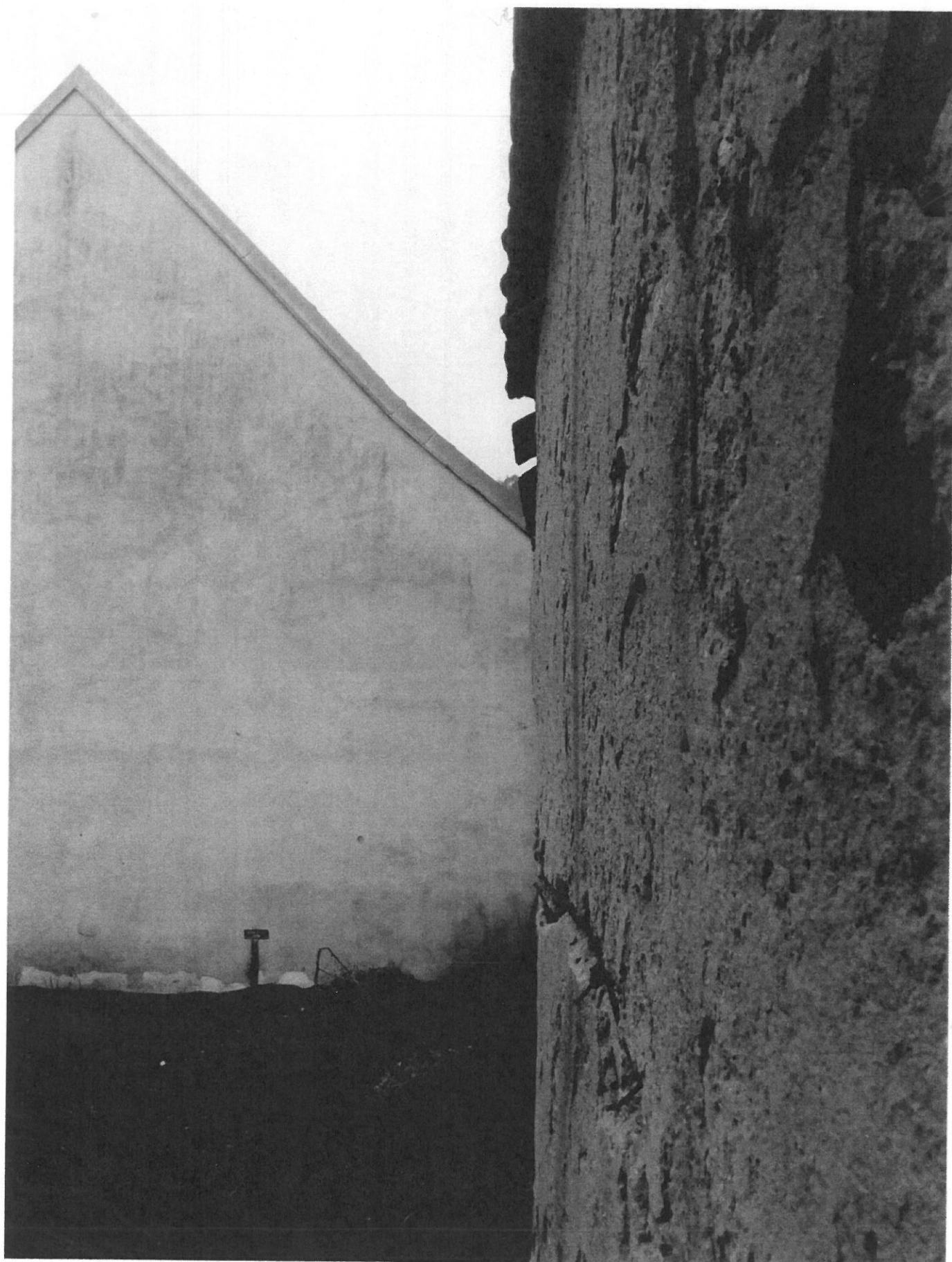
Vyboulená zeď sousedící s Lesy města Brna. Pohled z farního pozemku.
