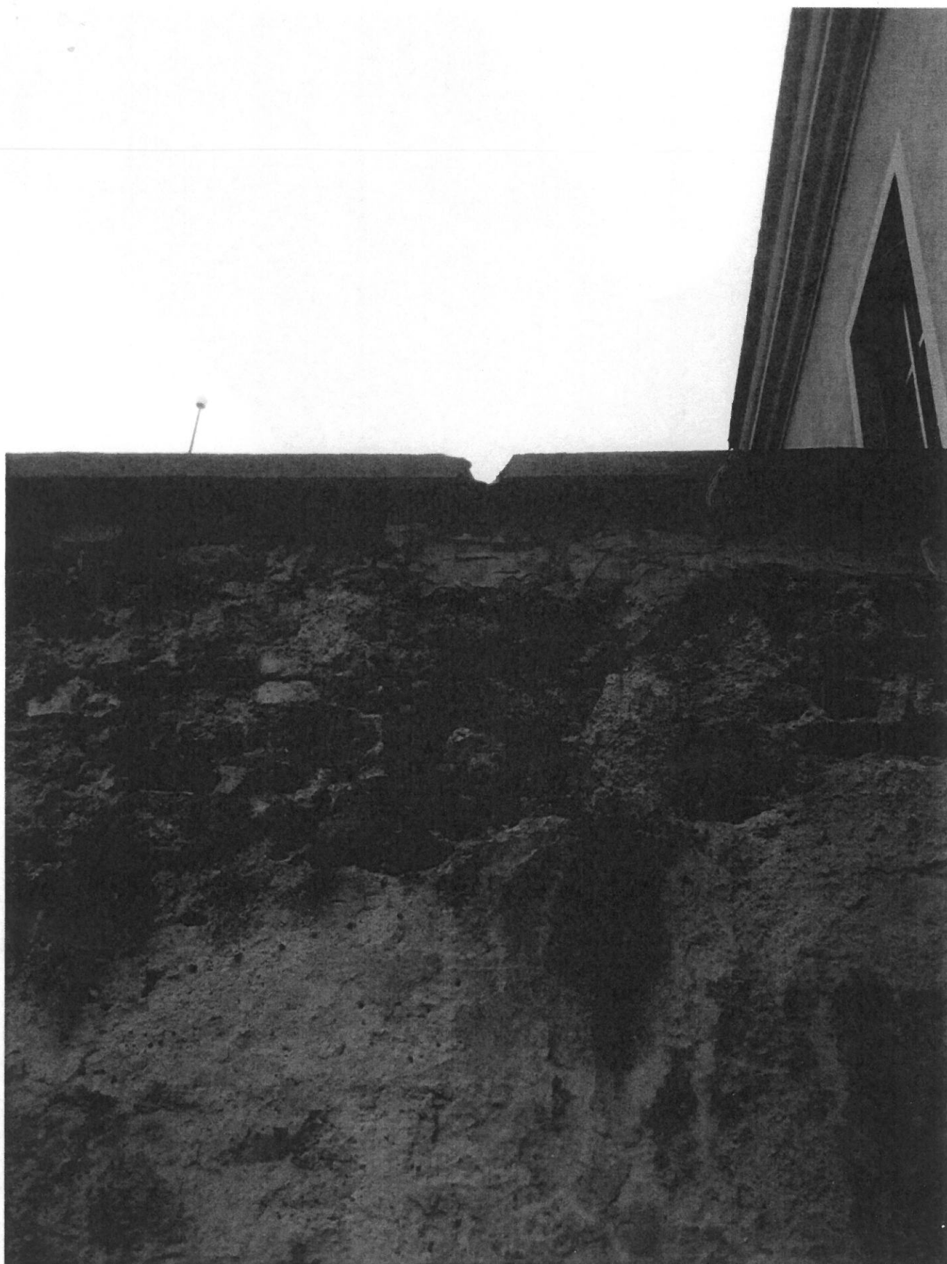
Detail prasklé betonové krycí desky, zvětralá a opadaná omítka. Výskyt plísní. Pohled z farního dvora.
