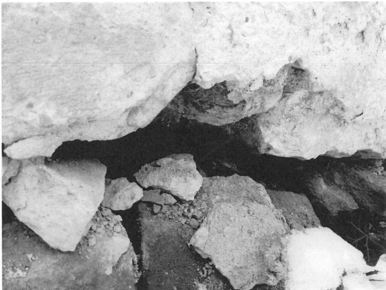
Utržená spára zdiva a základů ze strany farního pozemku.
