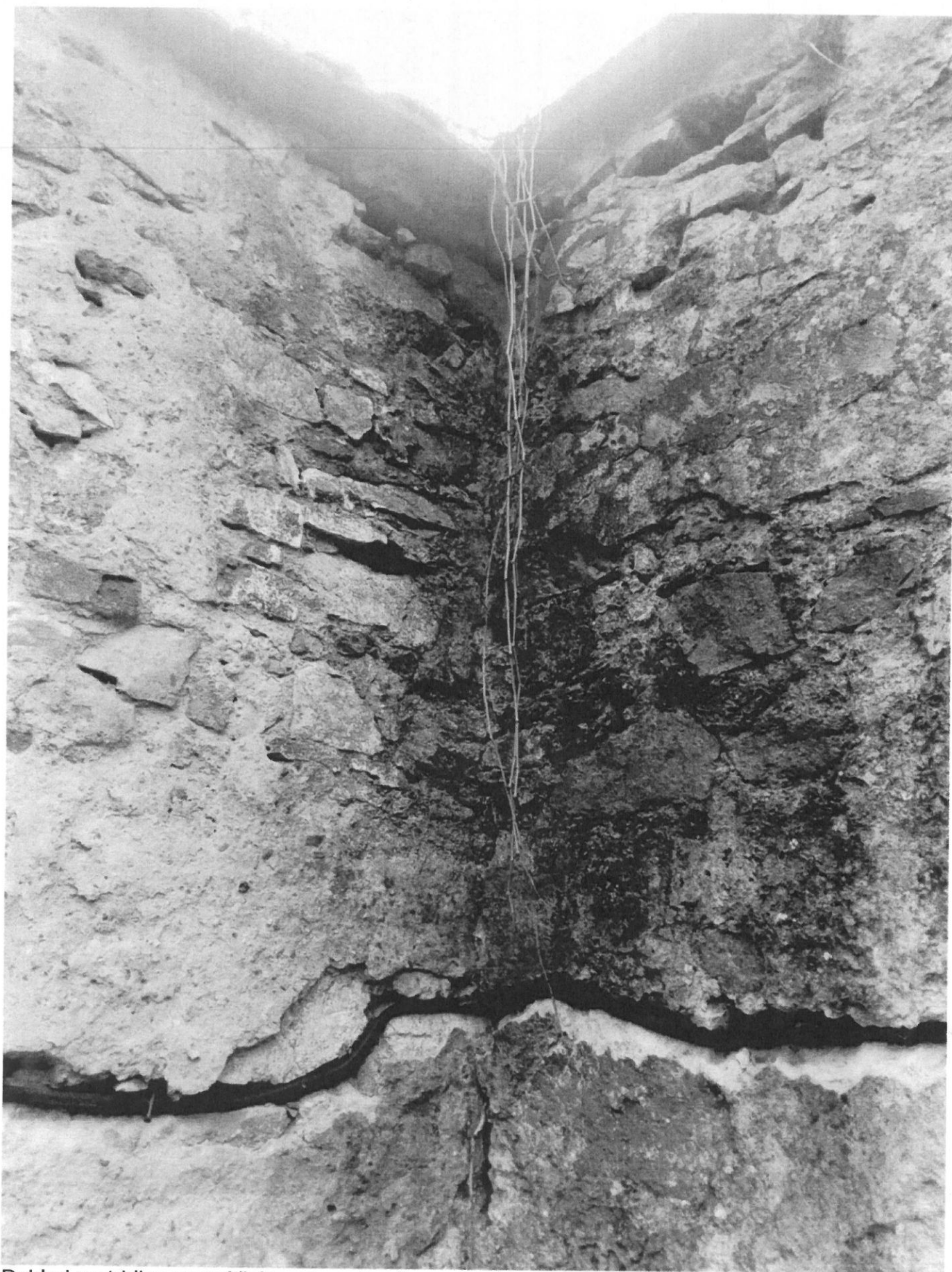
Pohled na trhlinu ve vnitřním rohu z farního pozemku.
