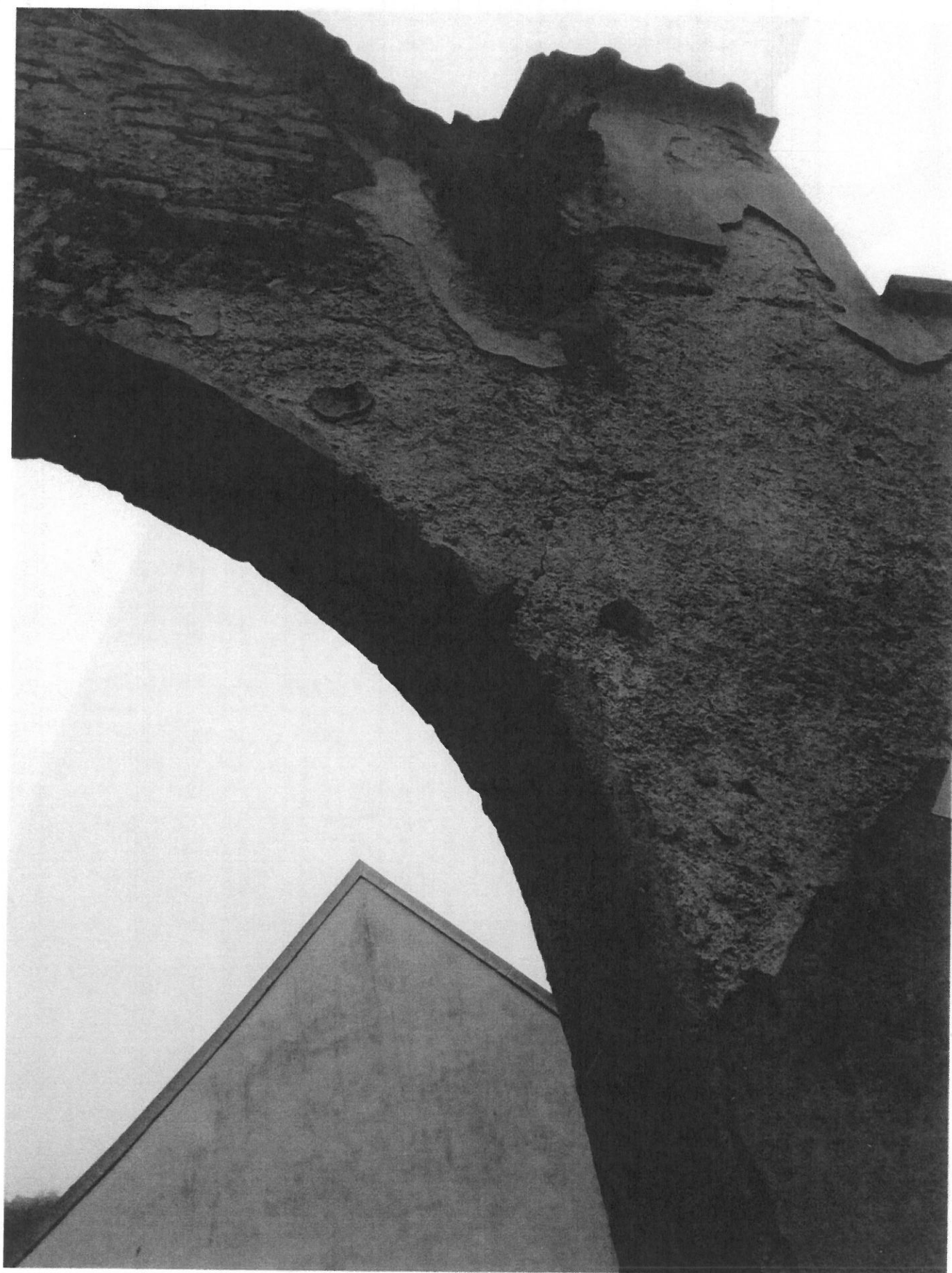
Prasklina paty klenby, zvětrané zdivo a plíseň způsobená zatékáním narušenou krytinou. Pohled od komunikace. (pravá strana)
