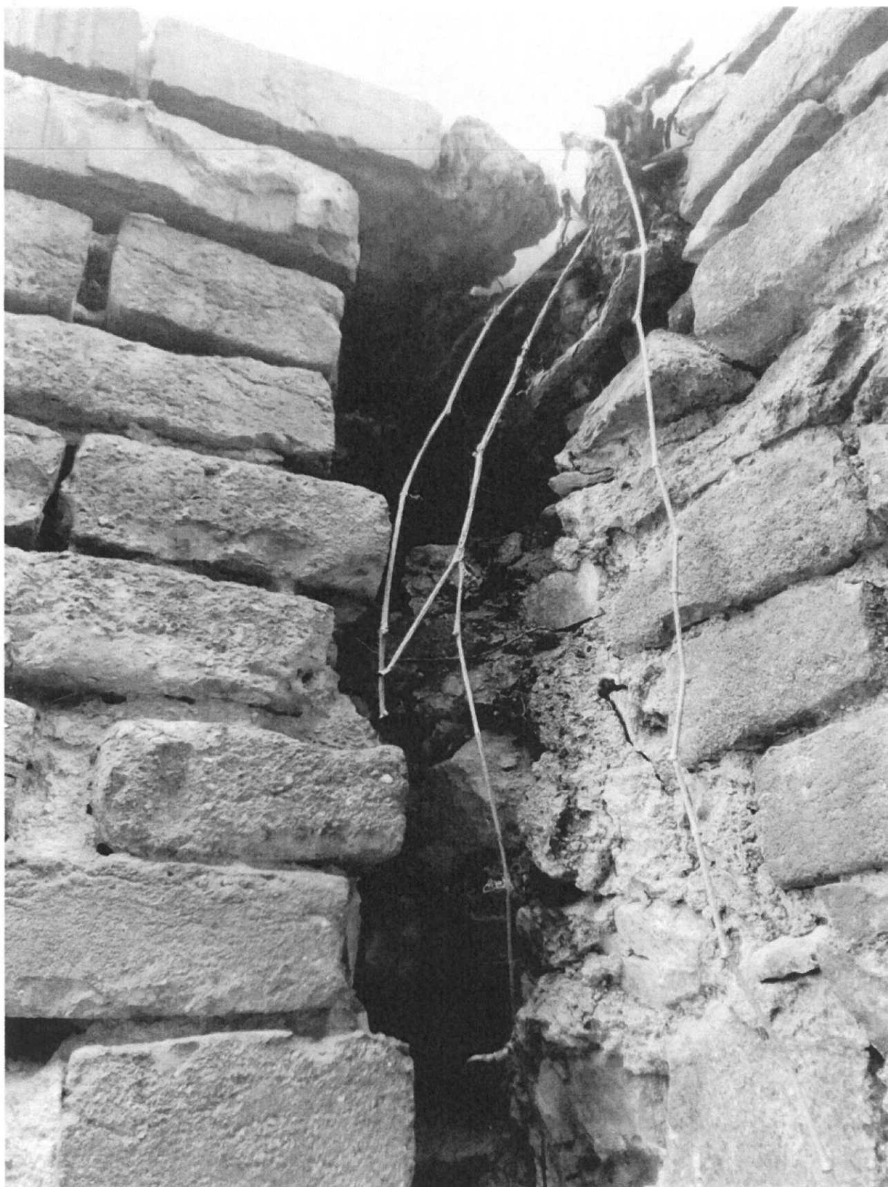
Trhlina u horní části zdiva.
