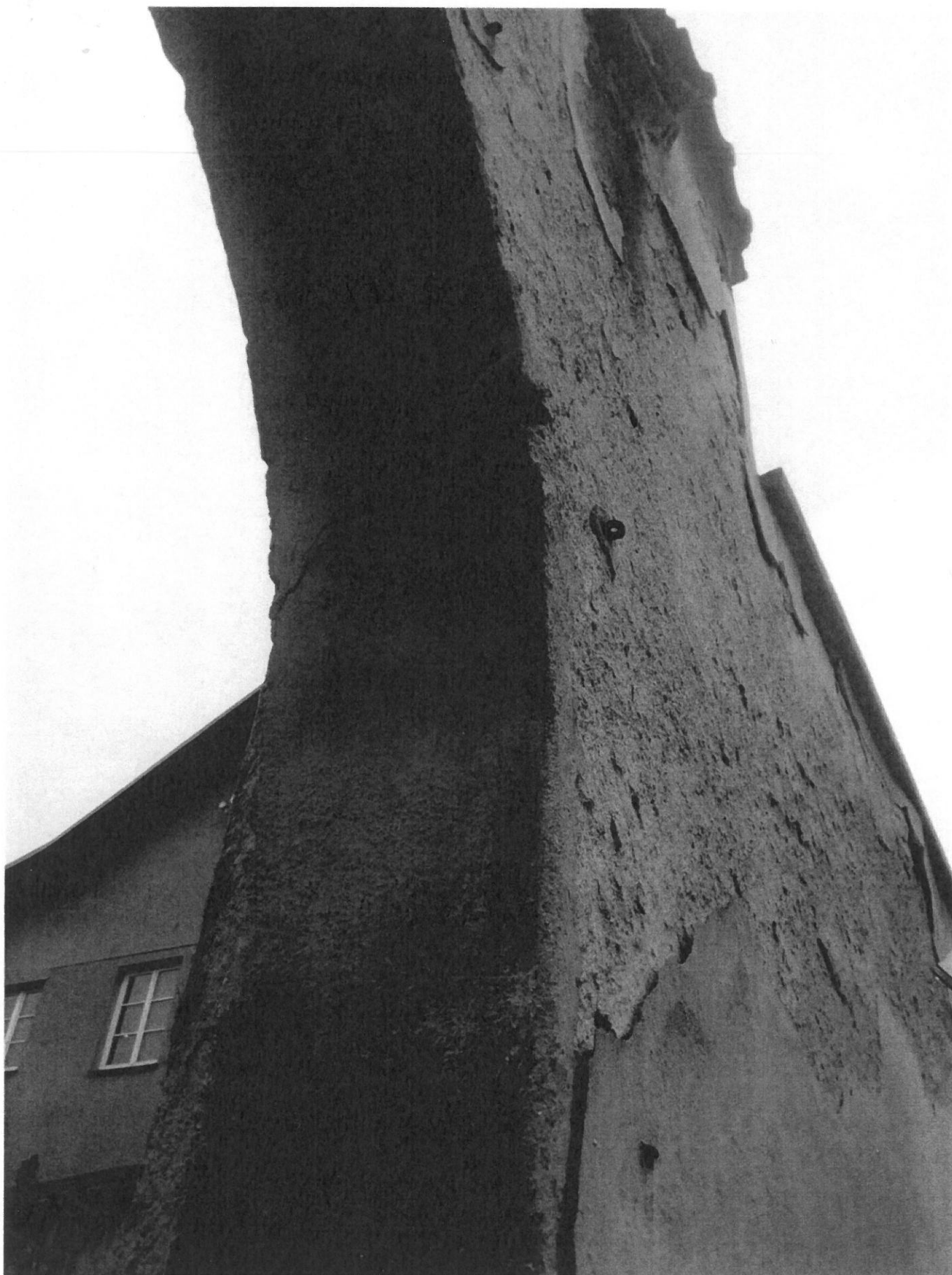
Detail praskliny paty klenby. Pohled od komunikace. (pravá strana)
